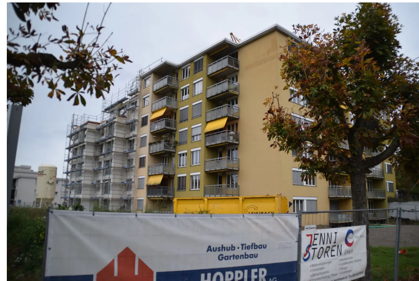
Die Mehrfamilienhäuser an der Klosterfeldstrasse 23 und 25 werden totalsaniert.
